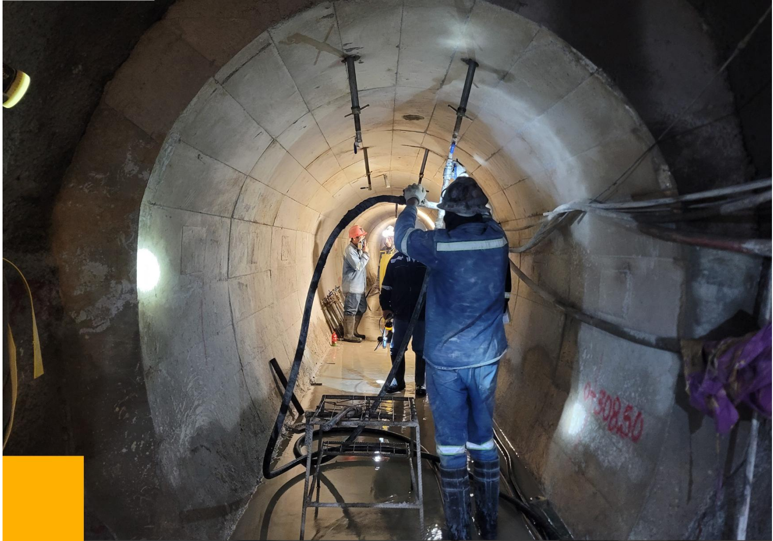
TÚNEL DE ADUCCIÓN
