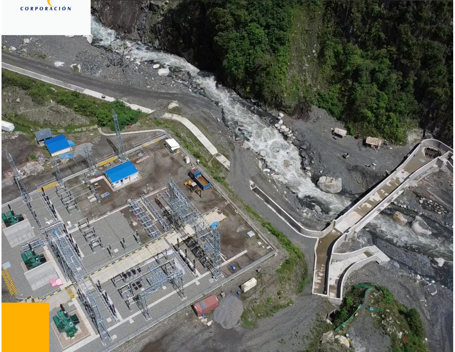
SUBESTACIÓN UMAPALCA, ACUEDUCTO JALANCHA
