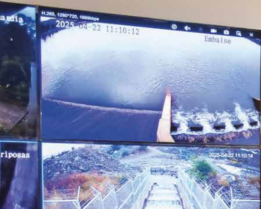
Sala de control de la Central Hidroeléctrica Misicuni
