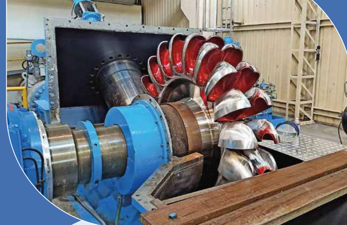
Ensayo de líquidos penetrantes al rodete Pelton de la Unidad Generadora N° 5 de la Central Hidroeléctrica Corani
