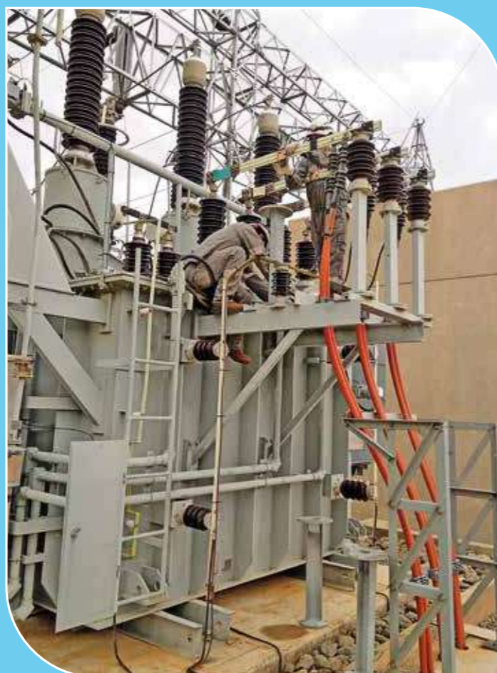
Montaje de pararrayos de media tensión en el transformador de potencia de la Subestación Qollpana
