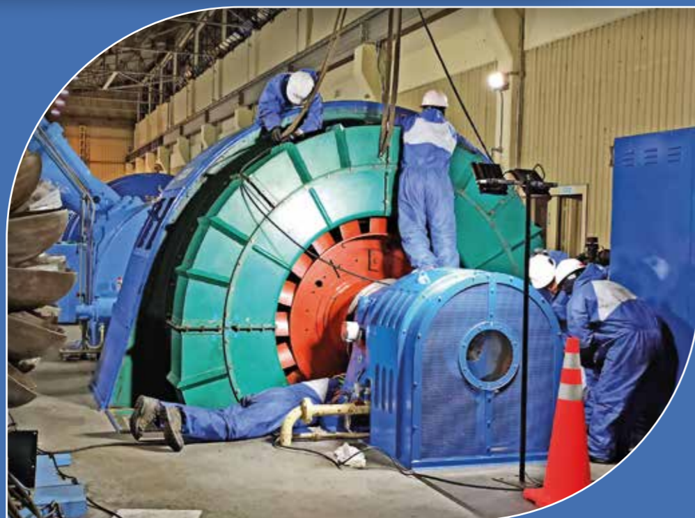
Mantenimiento de la Unidad Generadora N° 3 de la Central Hidroeléctrica Corani
