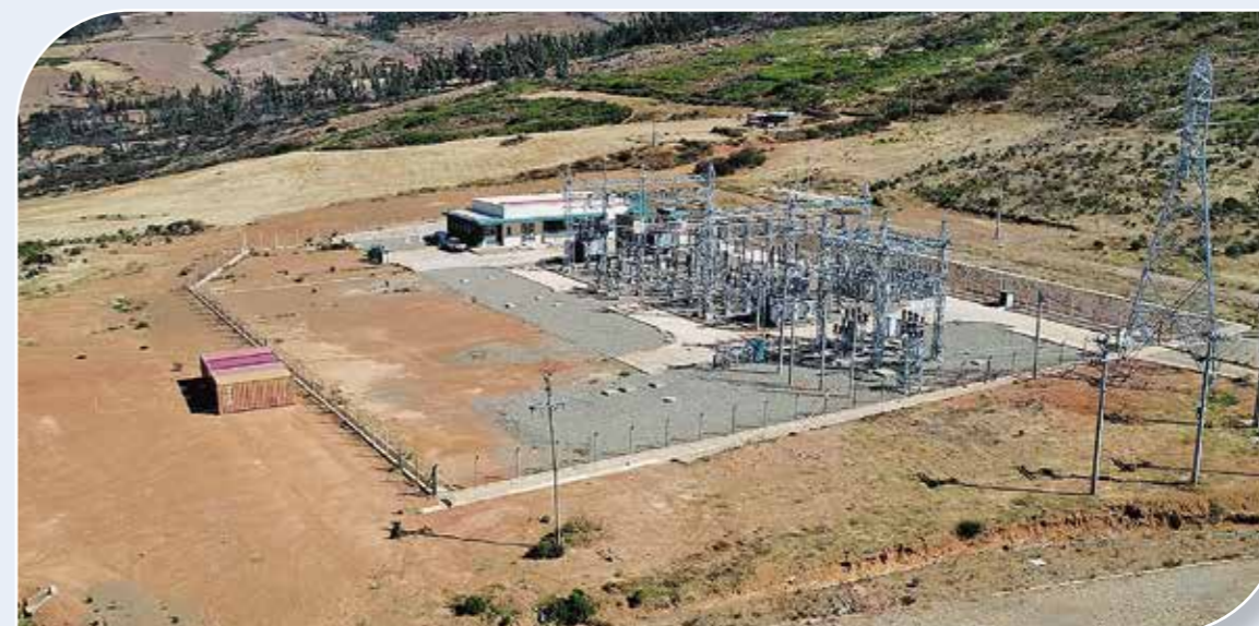
Vista aérea de la Subestación Qollpana
