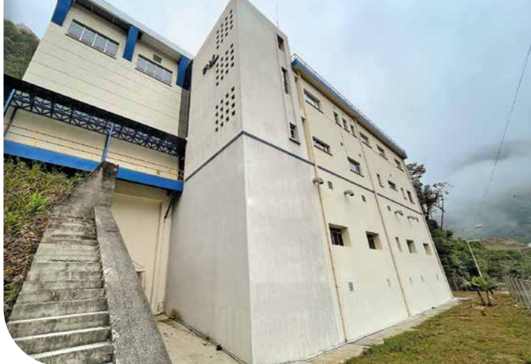
Casa de máquinas de la Central Hidroeléctrica San José 2
