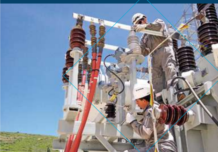
Cambio de pararrayos en la subestación del Parque Eólico Qollpana
