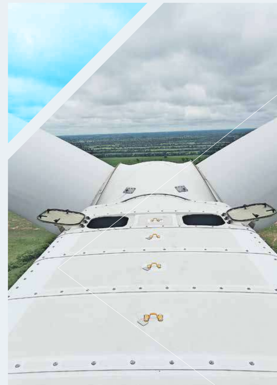
Vista del rotor - palas del aerogenerador del Parque Eólico San Julián
