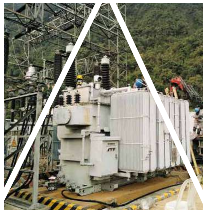
Trabajos de cambio de transformador de la unidad COR01 durante las jornadas de mantenimiento de los túneles y obras anexas de las centrales hidroeléctricas Corani y Santa Isabel
