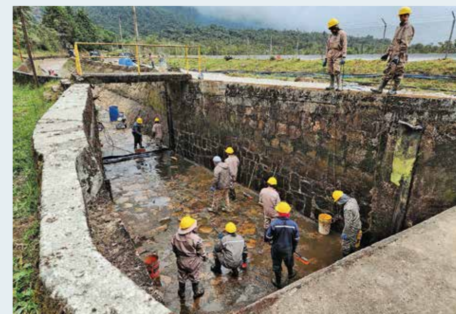
Trabajos de limpieza de canales de la Central Hidroeléctrica Corani
