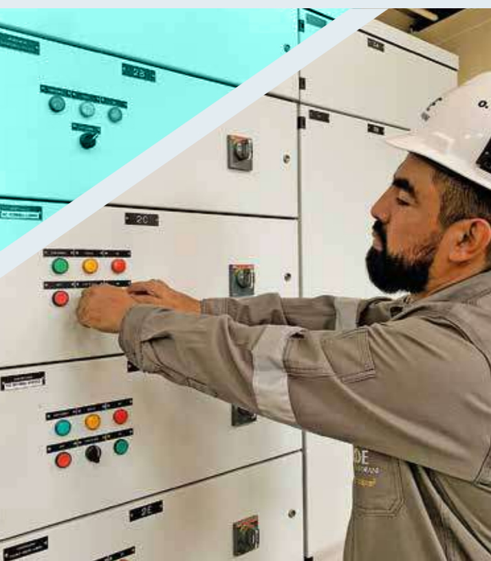
Pruebas de funcionamiento de bombas de lubricación en la Central Hidroeléctrica Misicuni
