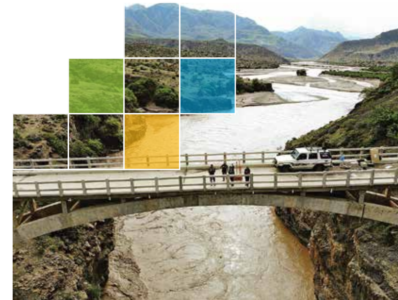
Estación hidrométrica puente Inca para la medición hidrosedimentológica (Proyecto Hidroeléctrico Cañahuecal)
