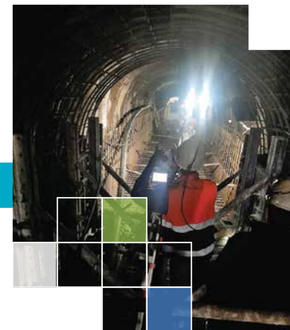
Trabajos de revestimiento del Frente F4 del túnel principal de conducción (Proyecto construcción de conducción subterránea y obras conexas de superficie del Proyecto Hidroeléctrico San José)
