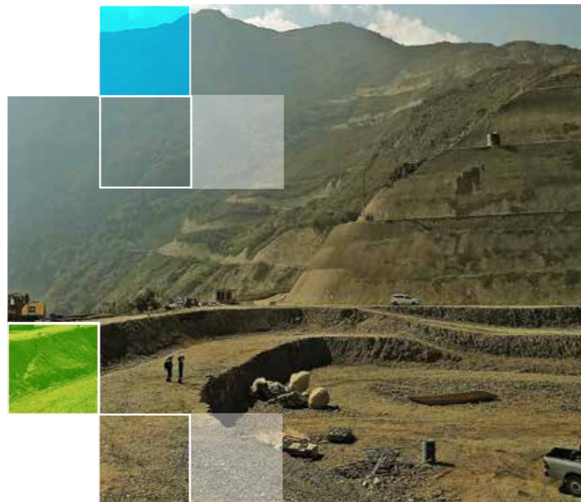
Cámara de carga del sistema Umapalca (Proyecto Hidroeléctrico Miguillas)
