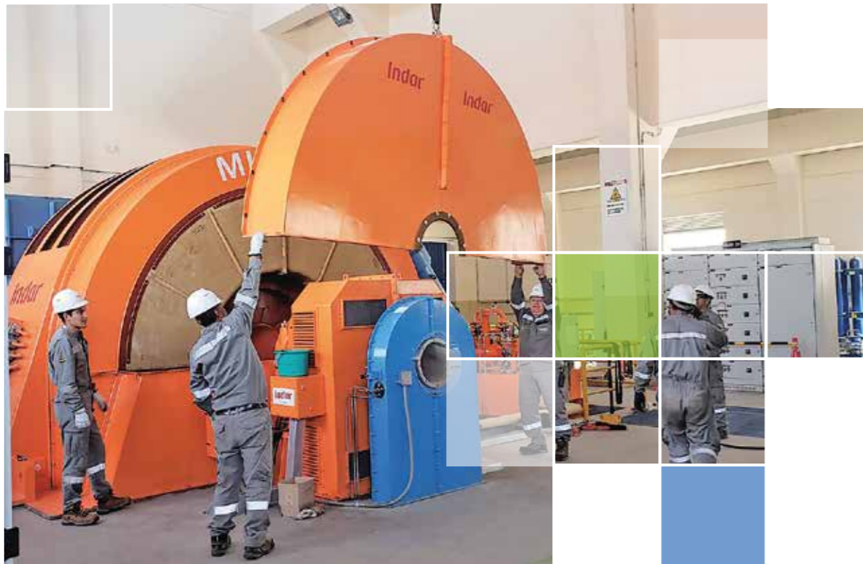
Mantenimiento preventivo de generador (Central Hidroeléctrica Misicuni)
