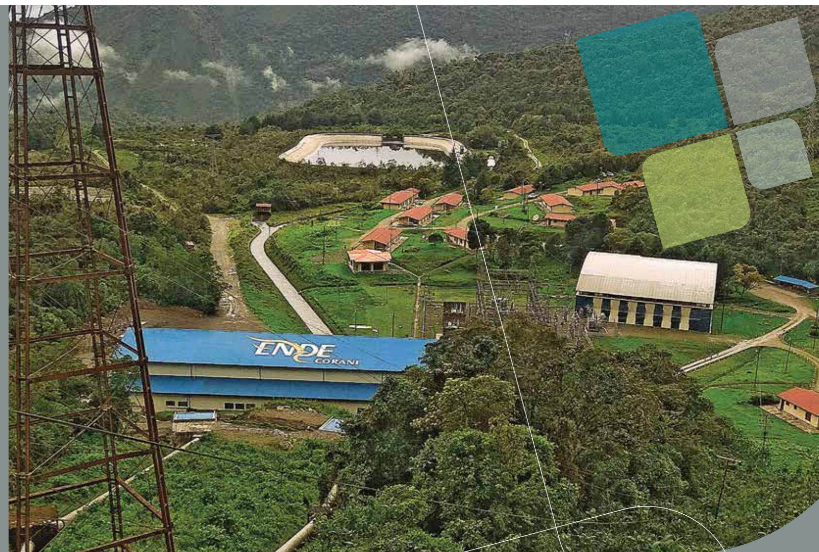
Vista panorámica actual de la Central Hidroeléctrica Corani
