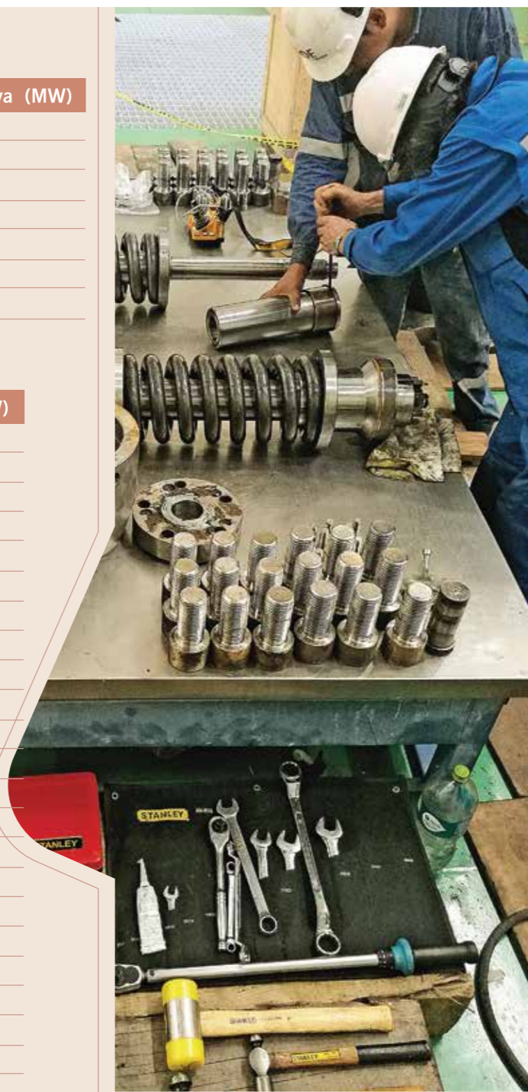
Despiece de inyectores del gobernador de una turbina de la Central Hidroeléctrica San José 2
