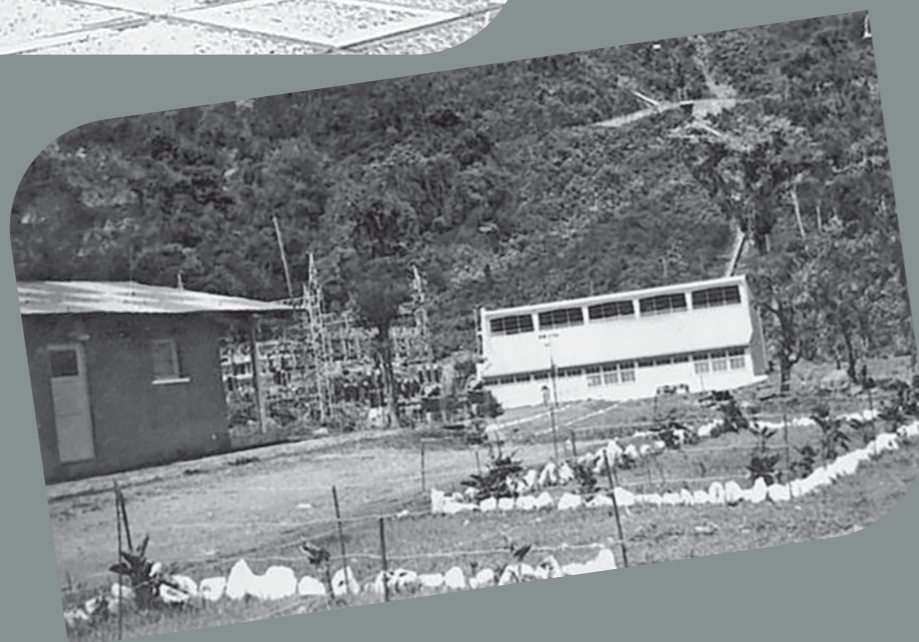
Primeros años de funcionamiento de la Central Hidroeléctrica Corani
