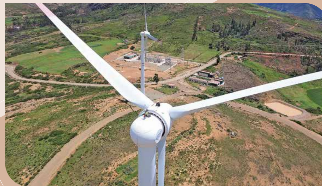
Inspección externa de góndola y palas en aerogeneradores del Parque Eólico Qollpana
