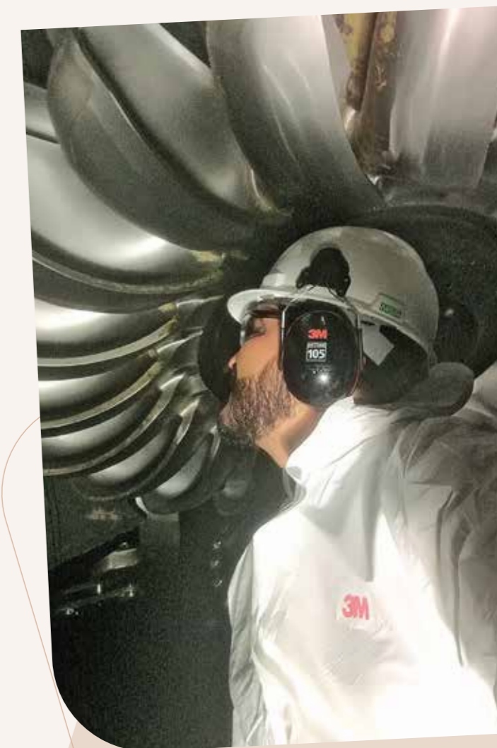
Inspección de tintas penetrantes durante el mantenimiento predictivo de rodetes
