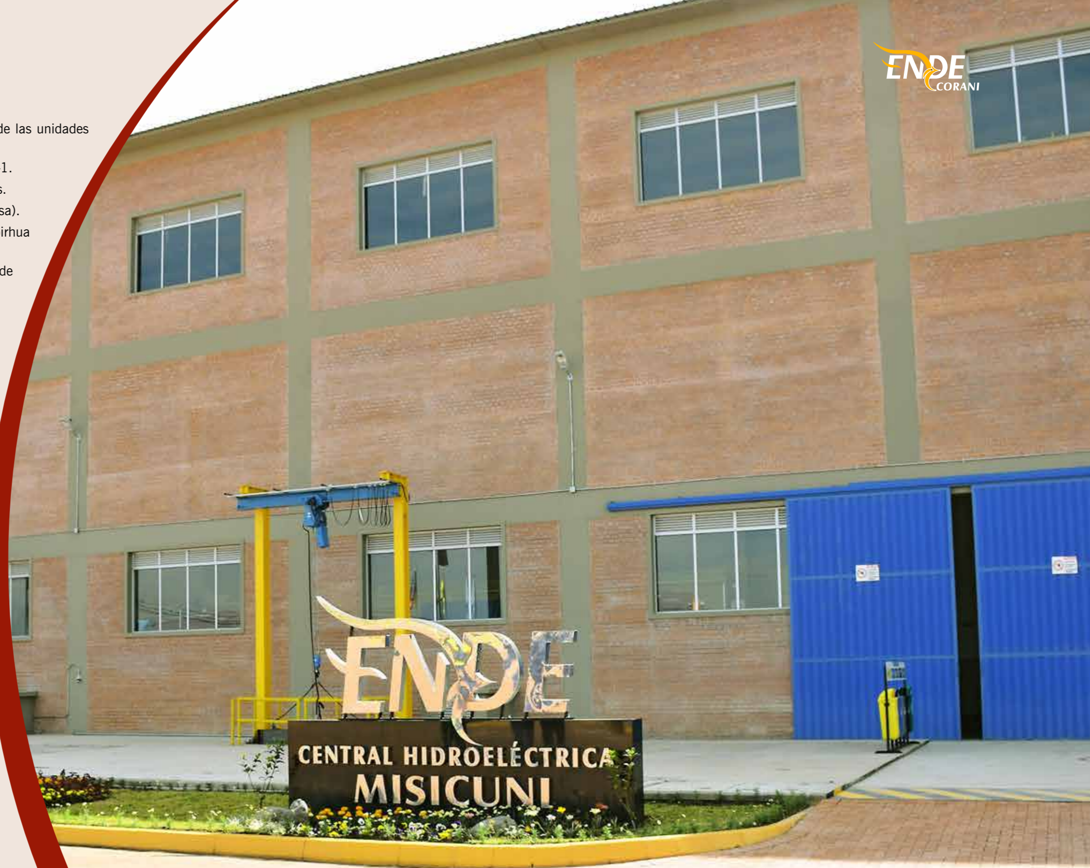
Fachada de la Central Hidroeléctrica Misicuni.
