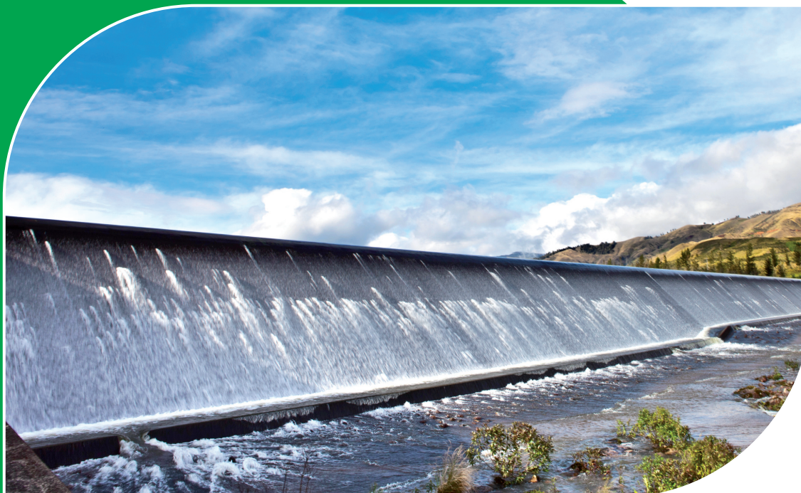
Vertedero Presa Corani
